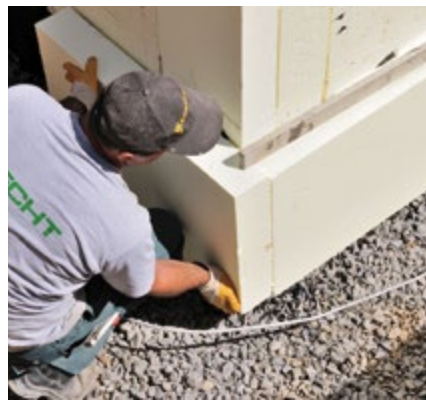
Anbringen der im Werk vorgeschneittenen Dämmstreifen an den Wandstößen und im Sockelbereich
