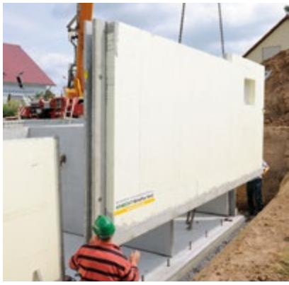
Montage der Wandelemente
