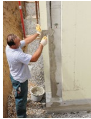
Schließen und Abdichten des Fugenbereichs
