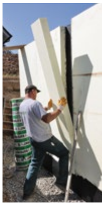
Anbringen der im Werk vorgeschneittenen Dämmstreifen an den Wandstößen und im Sockelbereich
