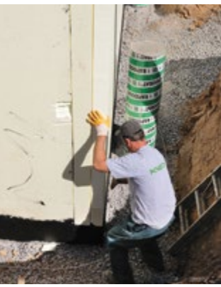
Anbringen der im Werk vorgeschneittenen Dämmstreifen an den Wandstößen und im Sockelbereich
