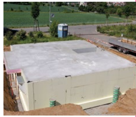
Durchgängig gedämmter Keller ohne Wärmebrücken in höchster Qualität
