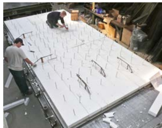
Einsetzen der Thermoanker in die Wärmedämmung
