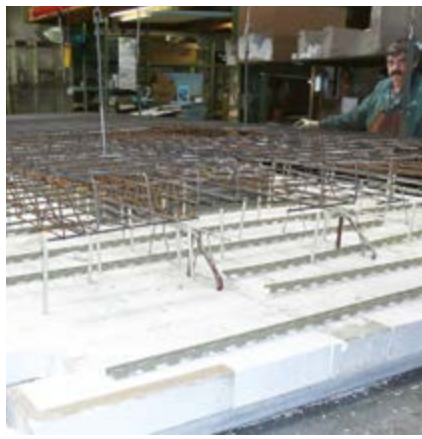
Einbringen weiterer Bewehrungslagen
