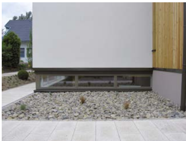
Das Lichtband taucht die Kellerräume auf wundervolle Weise in neues Licht.
