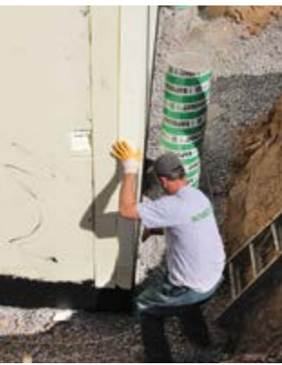
Anbringen der im Werk vorgeschnittenen Dämmstreifen an den Wandstößen und im Sockelbereich
