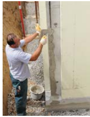
Schließen und Abdichten des Fugenbereichs
