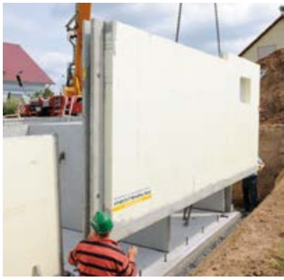
Montage der Wandelemente
