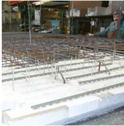
Einbringen weiterer Bewehrungslagen
