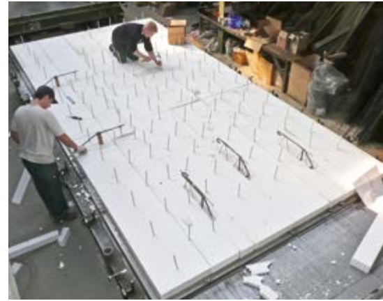
Einsetzen der Thermoanker in die Wärmedämmung
