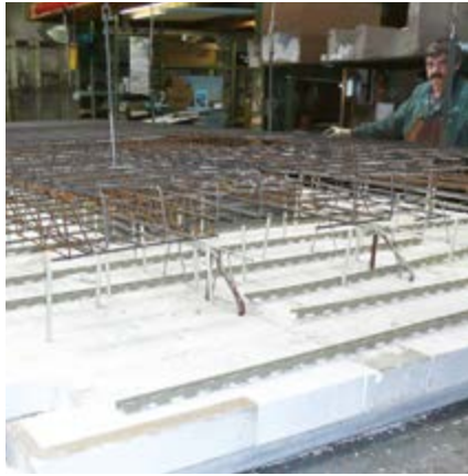
Einbringen weiterer Bewehrungslagen
