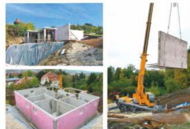
Durch exakte Planung lassen sich auch schwer zugängliche Grundstücke bebauen. Die im Werk vorgefertigten Wand- und Deckenelemente werden vor Ort aufgebaut und betoniert.
