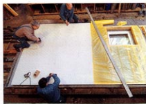
Die werksseitig vorgefertigte „warme“ Kellerwand: Auf das Betonfertigteil kommt die Holzkonstruktion, die mit Dämmstoff ausgefüllt wird. Anschließend folgt die Diffusionsbahn (gelbe PE-Folie) und zum Schluss die Bepan- kung mit Gipsfaserkarton!
