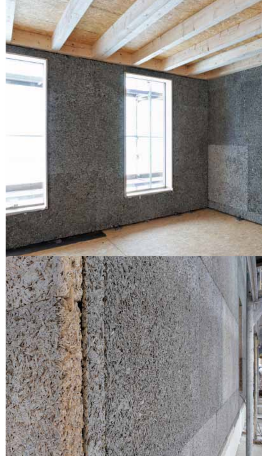
Die Eigenschaften und Einsatzmöglichkeiten der Holzbetonfertigteile werden im Forschungsgebäude auf dem Campus der Bauhaus-Universität Weimar untersucht
