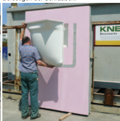
Aufsetzen des Lichtschachtes an die vorbereitete Stelle. Befestigen der Schrauben.
