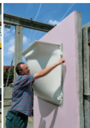
Aufsetzen des Lichtschachtes an die vorbereitete Stelle. Befestigen der Schrauben.
