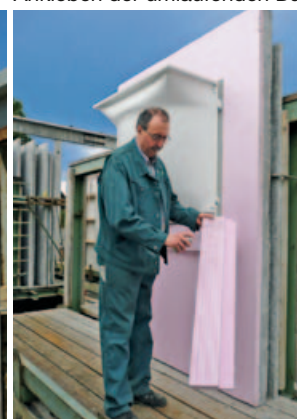
Ankleben der umlaufenden Dämmung.
